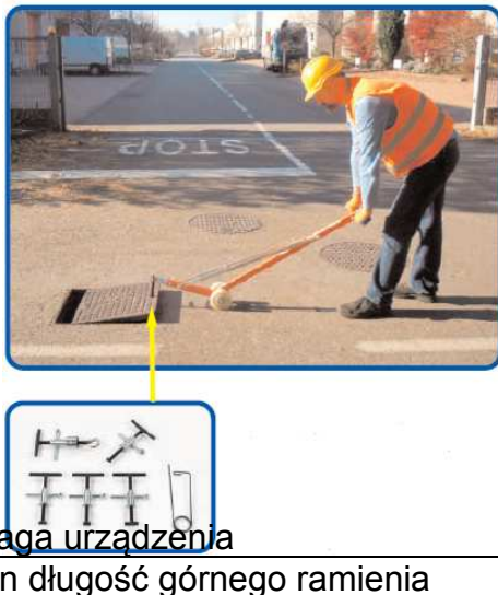
Z dwoma magnetycznymi podnośnikami połączonymi trawersem
